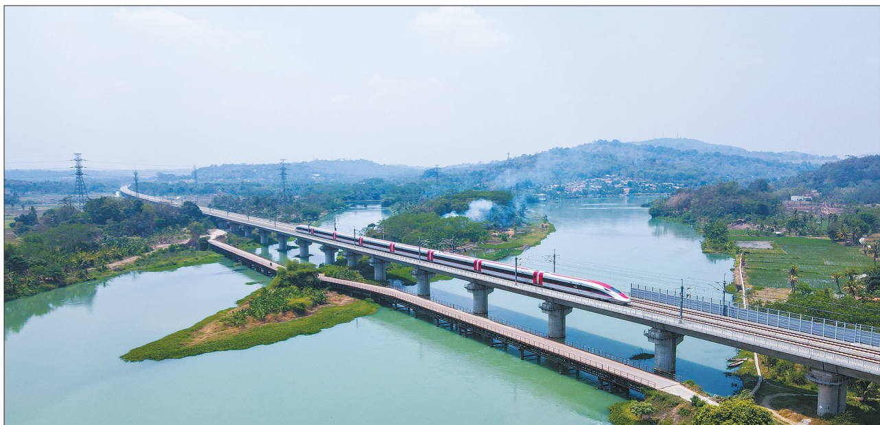
今年恰逢共建“一带一路”倡议提出十周年。十年来,“一带一路”倡议合作硕果累累,陆续建成的一系列标志性项目助力各国发展,为各国人民带来实实在在的好处。从空中俯瞰,这些“国家地标”尽显恢弘大气,成为“中国建造”的闪亮名片。这是2023年9月30日在印度尼西亚普哇加拍摄的一列行驶中的雅万高铁高速动车组(无人机照片)。雅万高铁是印尼和东南亚第一条高速铁路,是中印尼两国高度关注的共建“一带一路”旗舰项目,是国际上首个由政府主导搭台、两国企业合作建设和管理的高铁项目。 新华社记者 徐钦 摄
