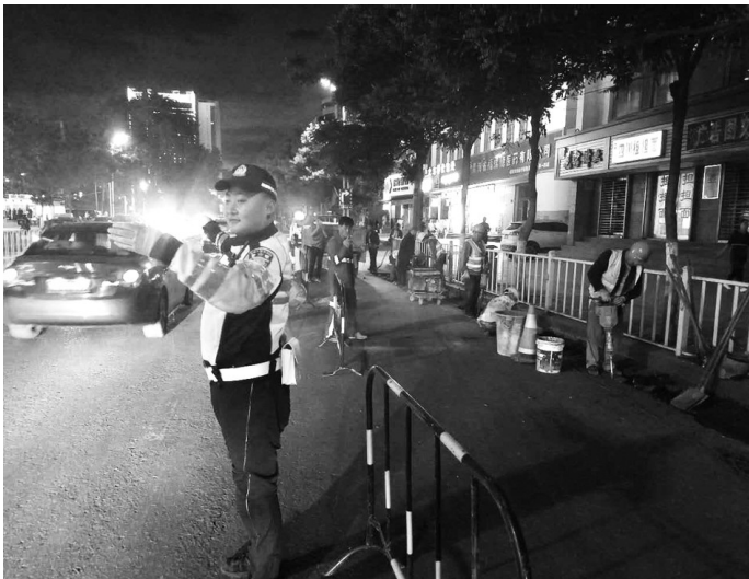
7月10日晚,西宁市交警支队三大队民警在夜间巡查时发现,因市政工程修复路面,导致五四大街由东向西方向发生拥堵,民警在全力疏导交通的同时督促施工单位尽快完工,恢复路面通行秩序。 强中仁 摄影报道
