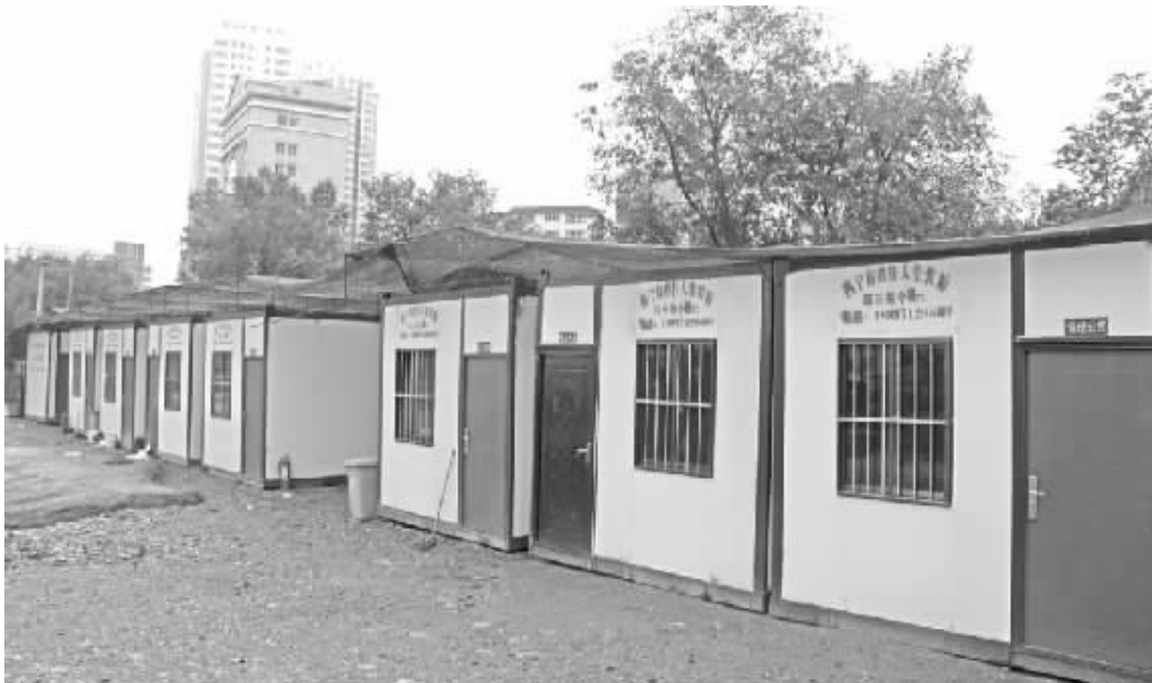
8月5日,记者在西宁市中心广场北广场扩建工地现场看到三十多个集装箱,上面写着“西宁房族住人集装箱,每天每个8元”。住在里面的工地工作人员介绍,这些集装箱租赁房是公司为他们租的。目前,西宁一些大的建筑工地上都出现了这种出租的集装箱房。
